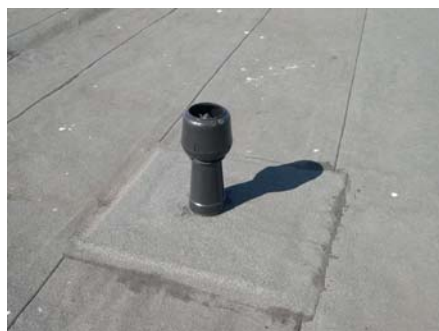
Foto 10. Katuse soojustamise käigus tehtud augud edaspidi kasutatakse katuse tuulutamiseks
