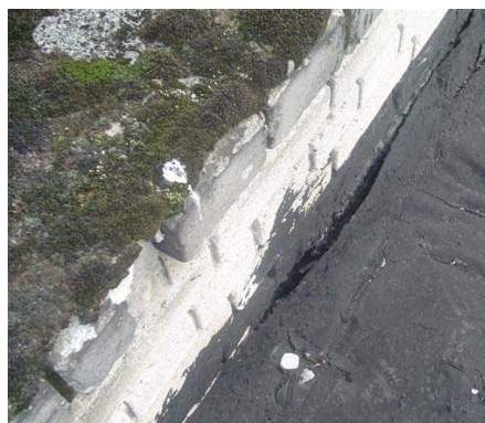
Foto 4. Katusekate liitekoht ventilatsiooni korstnaga
