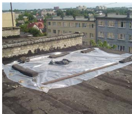
Foto 5. "Vaatamisväärne" katuse renoveerimis vüs.
