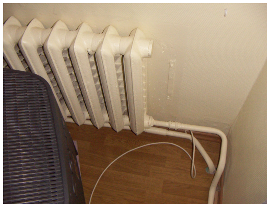
Joon.8. Magamistoa radiaator ja ühendustorud
