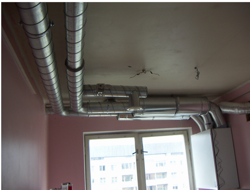
Joon.27. Ventilatsiooniagregaat ühenduskanalite ja mürasummutitega (köök).
