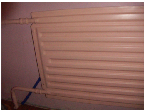
Joon.9. Köögi radiaator (PCF) ja ühendustorud
