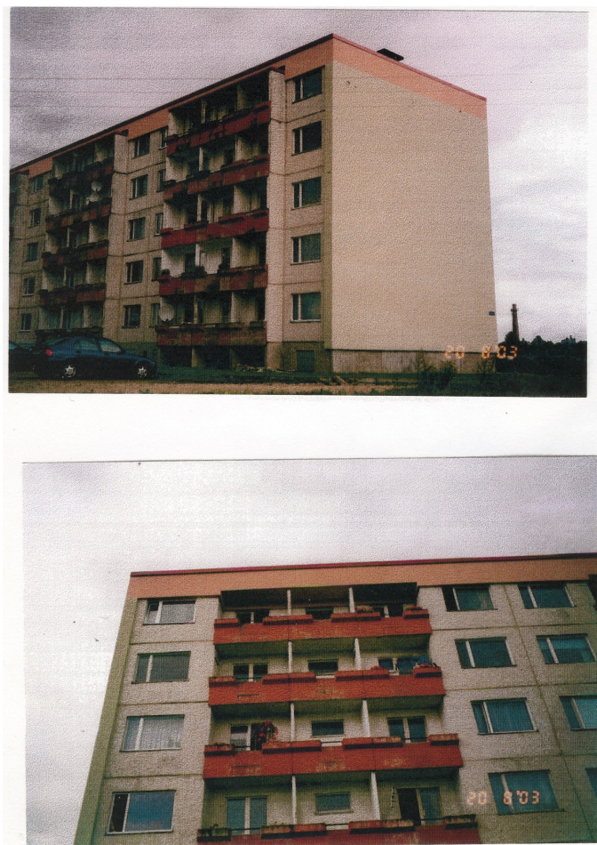
Joon.19. Piltidelt on näha välisseinte ülemiste osade lisasoojustamise alad
